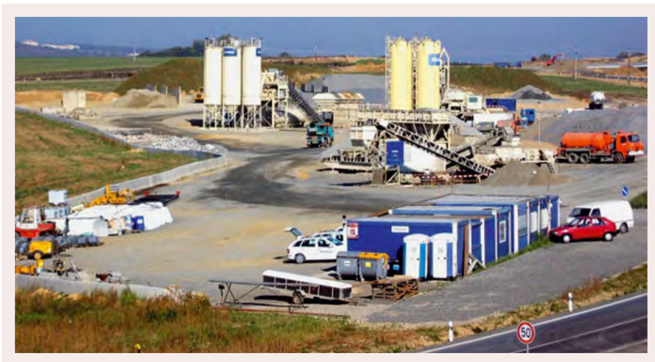
Obrázok 10: Zostava betonárni DUOMAT 250 a SGME 320 na stavenisku Vítkovice (zdroj: www.asb.sk/stavebnictvo/zaklady-a-hruba-stavba/cement-beton/vyroba-cerstveho-betonu-vbetonarnach )
